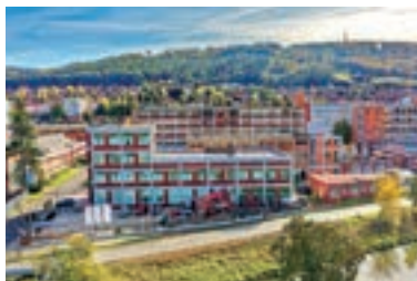
Industriální areál / Industrial complex
